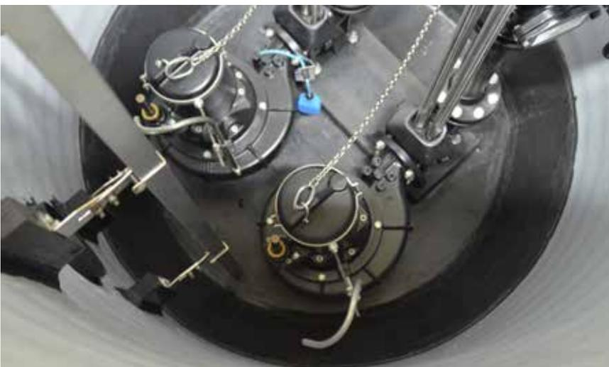
► Pumpen mit Spülrohr
